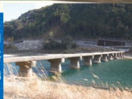
片岡・沈下橋
