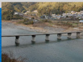
鎌井田・沈下橋
